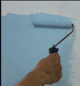
1. 以Y字型滾塗方式上塗底色漆。
