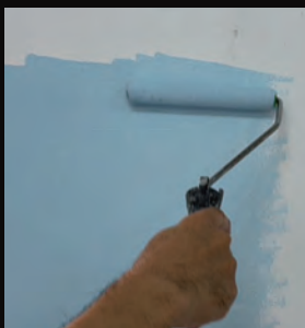
1. 以Y字型滾塗方式上塗底色漆。
