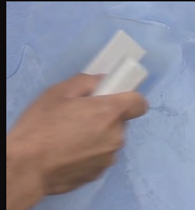
3. 使用塑膠批刀將面漆材料薄批一部份面積。 4. 將批刀多餘漆料清理乾淨。 5. 將批刀以平面貼平牆面畫8字型方式，進行不規則繞法產生紋理即可。
